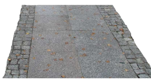
Sposób układania nawierzchni z płyt betonowych i kostki granitowej
